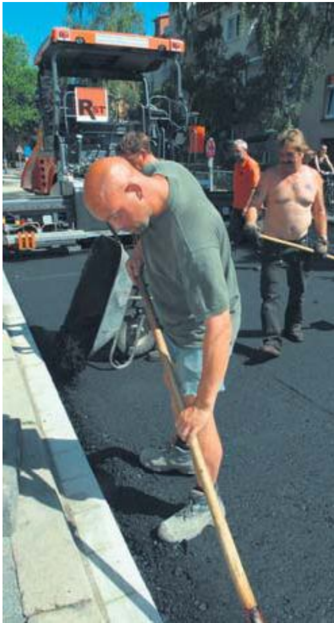
Zu eng für die Maschine: Michael Wand bessert nach.
