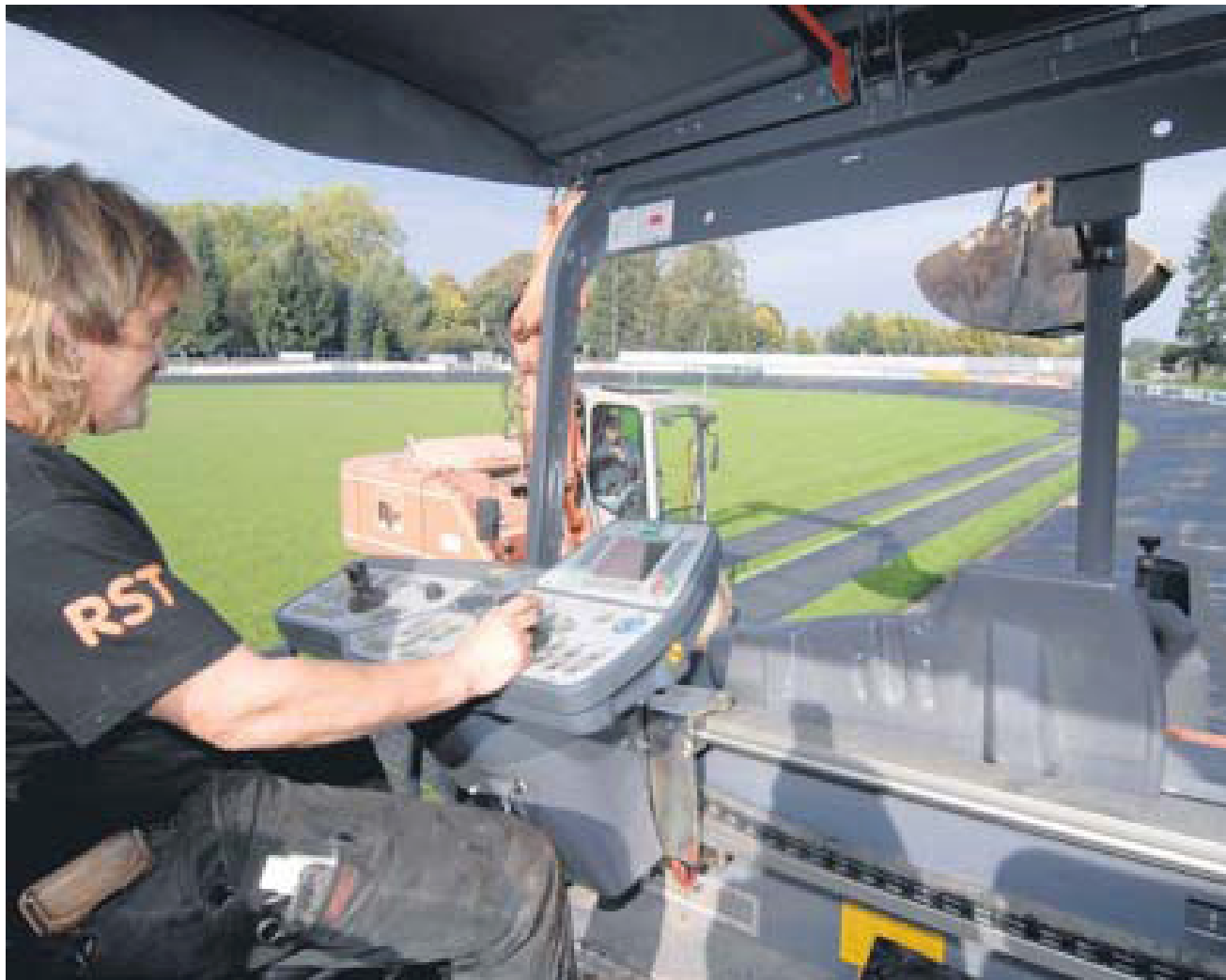
Mit schwerem Gerät im SVG-Stadion: Das Unternehmen RST trägt Asphalt auf.
