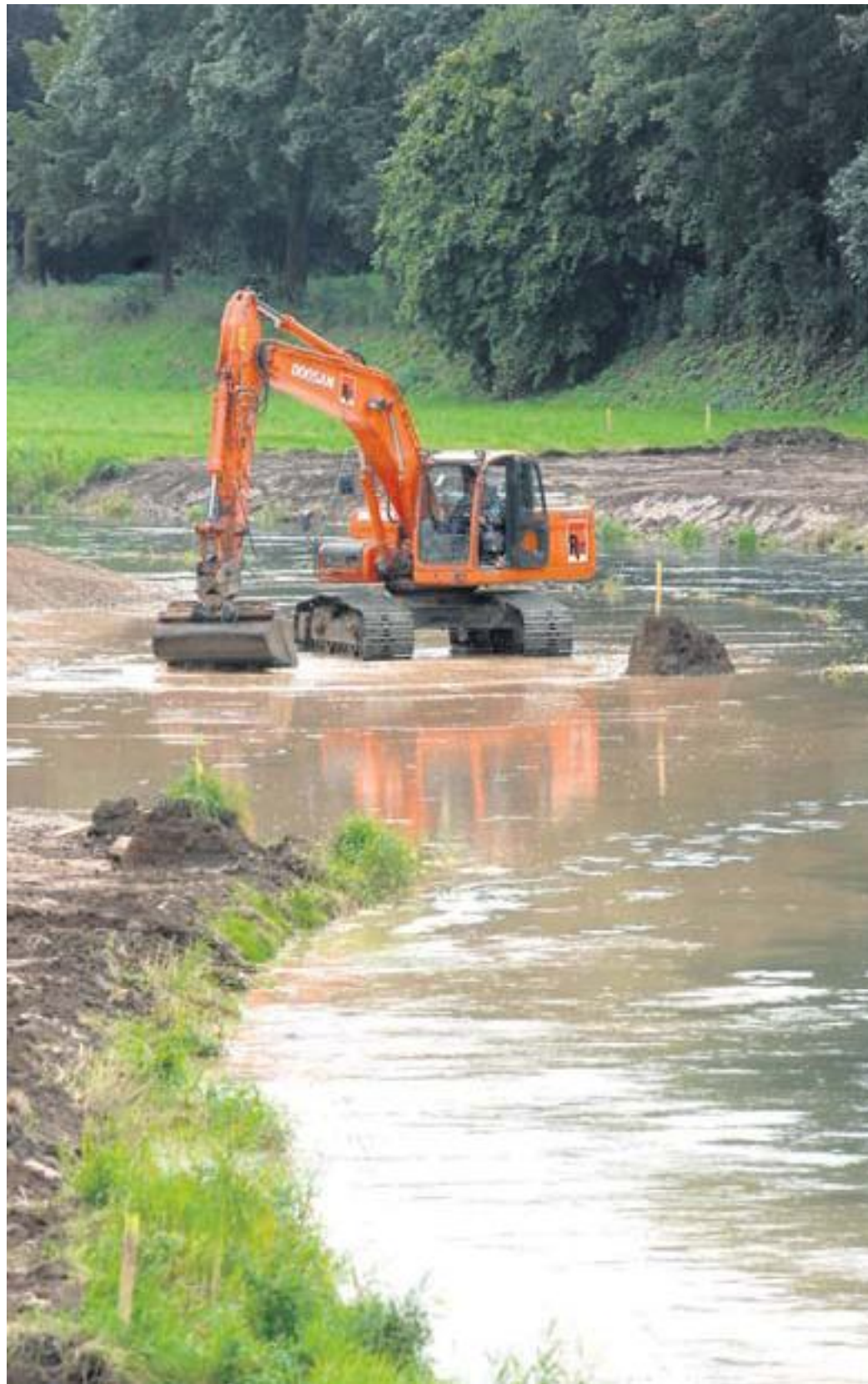
Baggern für den Hochwasserschutz: Die Leine soll so mehr Platz bekommen.
